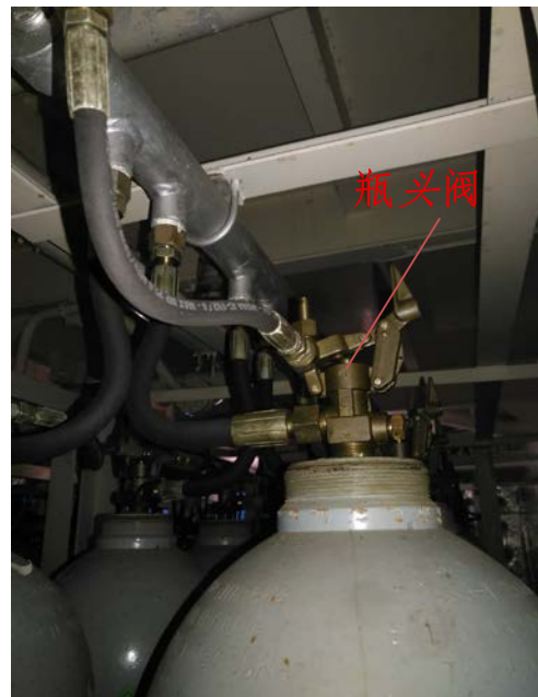
图2 瓶头阀（采自气瓶间）
